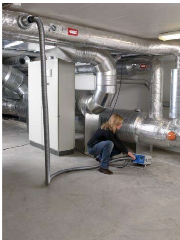
Figura 8. Prova di tenuta dei canali effettuata con LT510.
