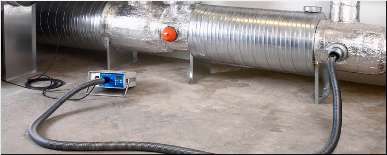
Figure 3 : Raccordement au système de conduits d'air
