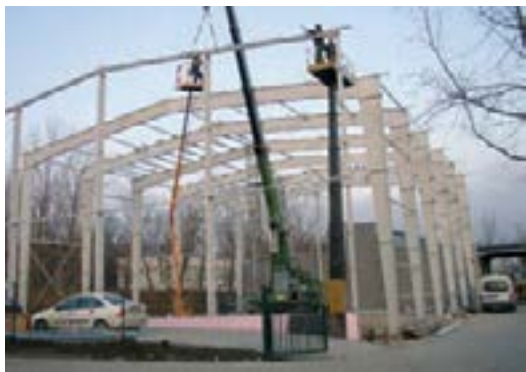
Épület: Beltex, Magasraktár Helyszín: Budaörs (Pest megye) Kivitelezés éve: 2004 Lindab termékek: komplett Systemline épület (vázszerkezet, szelemenrendszer, burkolati rendszer, tartozékok)
