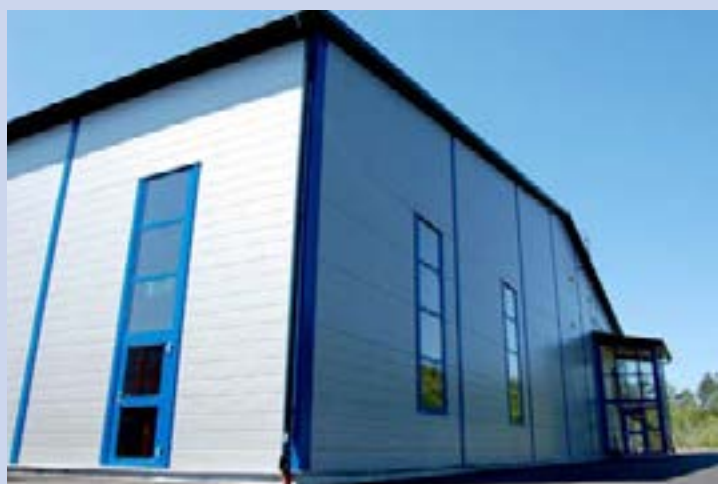
Épület: D-Aqua szolgáltató csarnok Helyszín: Paks (Tolna megye) Lindab termékek: Construline szelemen-rendszer, Coverline burko- lati rendszer, Rainline ereszcatorna-rendszer
