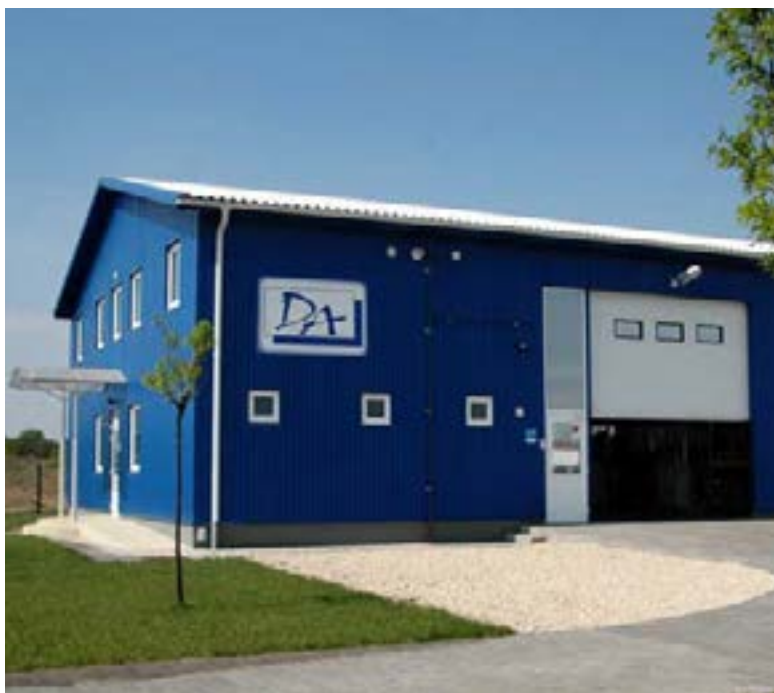
Épület: D-Aqua szolgáltató csarnok Helyszín: Paks (Tolna megye) Lindab termékek: Construline szelemen-rendszer, Coverline burko- lati rendszer, Rainline ereszcatorna-rendszer
