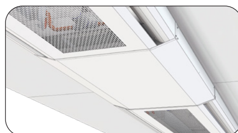
CC kåpan installerad (skruvarna är isatta).
