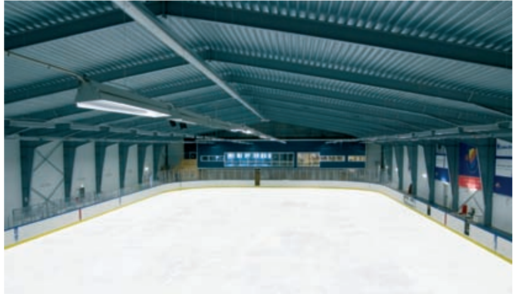
Épület: Műjégpálya csarnok, Svédország Alapterület: 2 500 m 2 Beépített Lindab anyagok: Lindab trapézlemezek
