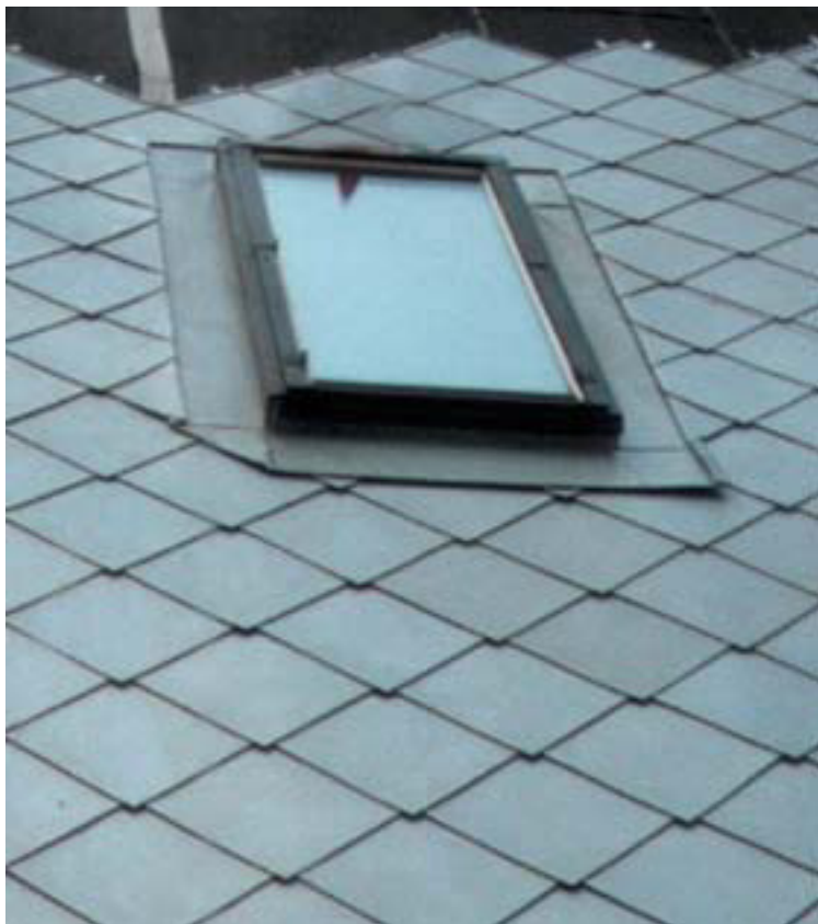
Tetőablak beépítése pikkelyes tetőfedésbe
