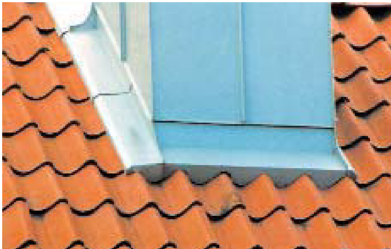
Kémény szegélyezése hullámcserepnél
