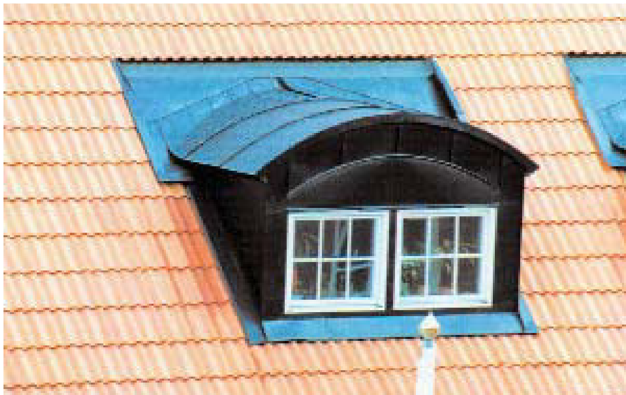
Tetőablak szegélyezése cserépfedésnél
