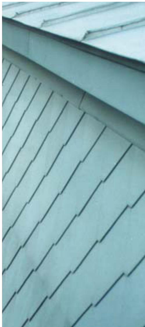
Korcolt tető és pikkelyfedés csatlakozása
