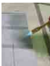
4. ábra: A filces lemezek végein a kapilláris vízfelszívódás megakadályozása (a) helyszínen égetéssel vagy (b) vízes bázisú lakkfestéssel
