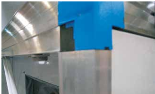
Bild 14: Sätt självhäftande EPDM-gummipackning med tvärsnittet 20 x 8 mm (medföljer aggregatet) på frontens kontaktytor (på höljets stomme) när sektionerna med aluminiumprofiler ska kopplas samman.
