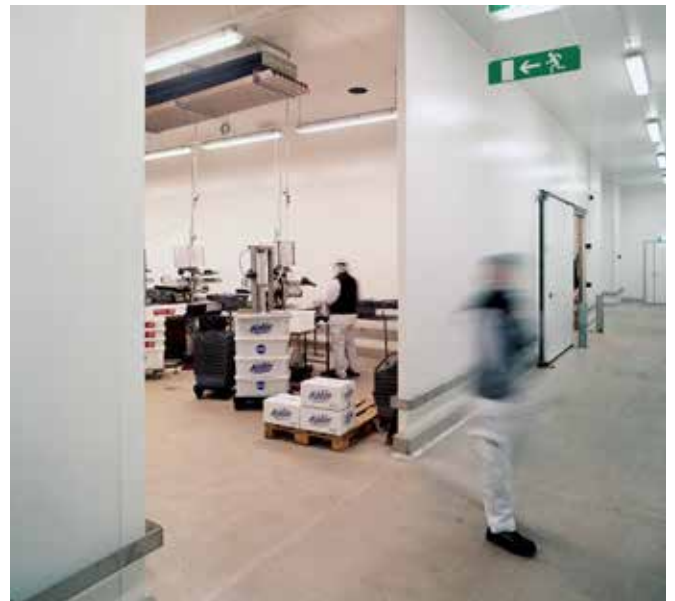
Lindab Panel 200. För att hindra att varm och fuktig luft kondenseras mot kylutrymmets kalla innersida tätas alla beslag och skarvar noga. Lindabs paneler med kärna av EPS, Expanderande Polystyren, är det naturliga valet tack vare utmärkta isolerande egenskaper och god byggekonomi. Här vit, stående Lindab Panel 200.
