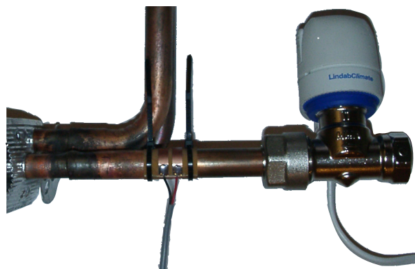
Figur 4 -Sensor fäst med 2 strips runt horisontellt kopparör.
