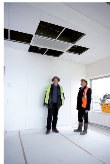
Plexus findes til både integreret og frithængende montage. Bundpladen kan placeres i niveau med loftet, så løsningen er fuldstændig integreret i loftet.
