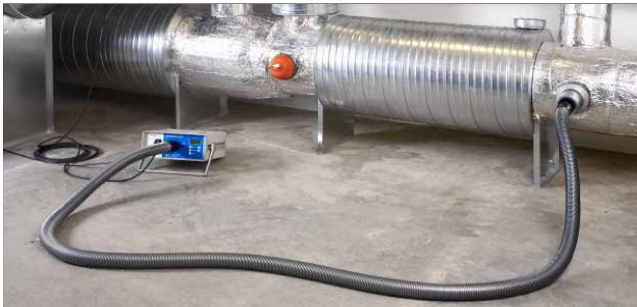
Bild 3: Anslutning till kanalsystemet
