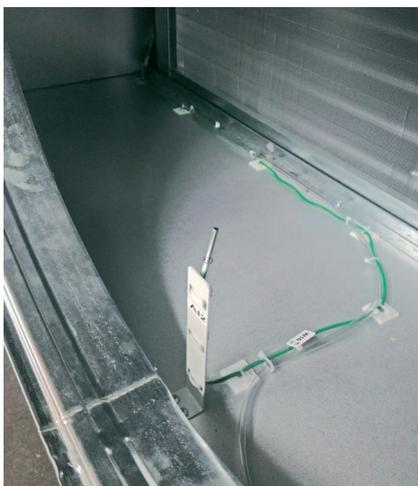
Abb. 52: Temperatursensor für die Ansaugluft. Dieser muss im Anschlusskasten hinter dem Zuluftventilator (grüner Steckverbinder, siehe Abb. 53) angeschlossen werden.
