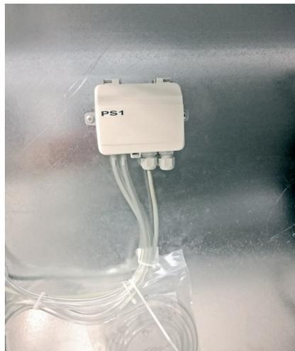
Abb. 50: Drucksensoreinheit mit zwei Differenzdruck-Sensoren. In CompAir-Geräten wird diese Einheit sowohl für die Messung des Drucks im Kanal als auch für die Messung des Luftstroms der Zuluft- und Abluftventilatoren verwendet. Die Kommunikation mit der Steuereinheit erfolgt via EXOline.
