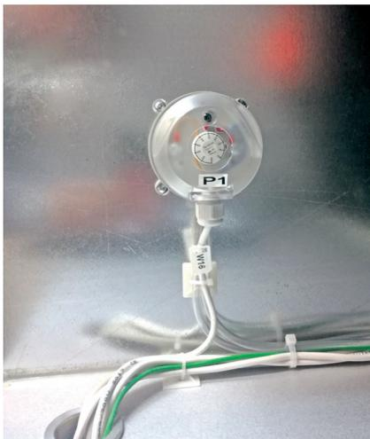
Abb. 49: Differenzdruckschalter für Frischluft- oder Abluftfilter.
