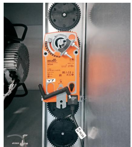
Abb. 54: Stellantrieb für Frischluft- und Fortluftklappen.
