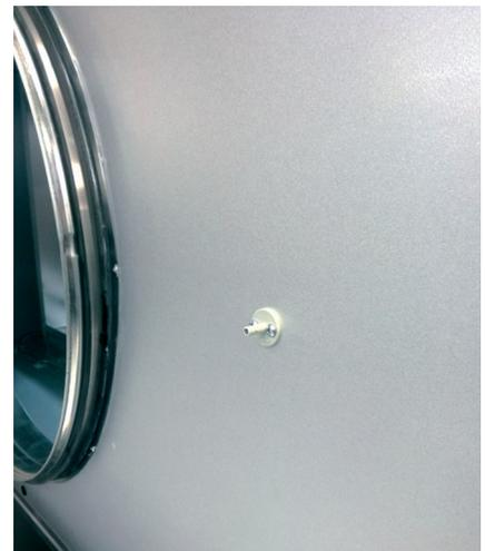
Abb. 51: Schlauchverbinder für die Messung des Kanaldrucks. Der Benutzer muss den beigefügten Schlauch am Verbinder anbringen. Das andere Ende muss am Luftauslasskanal angeschlossen werden. Das gleiche Verfahren ist auf der Einlassseite durchzuführen. Innerhalb von CompAir müssen die Schläuche an den Innenverbindern angeschlossen werden.
