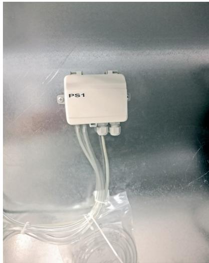
Abb. 49: Drucksensoreinheit mit zwei Differenzdruck-Sensoren. In CompAir-Geräten wird diese Einheit sowohl für die Messung des Drucks im Kanal als auch für die Messung des Luftstroms der Zuluft- und Abluftventilatoren verwendet. Die Kommunikation mit der Steuereinheit erfolgt via EXOline.
