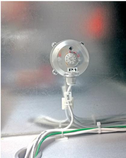
Abb. 48: Differenzdruckschalter für Frischluft- oder Abluftfilter
