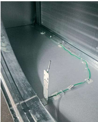
Abb. 51: Temperatursensor für die Ansaugluft. Dieser muss im Anschlusskasten hinter dem Zuluftventilator (grüner Steckverbinder, siehe Abb. 52) angeschlossen werden.
