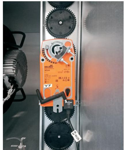
Abb. 53: Stellantrieb für Frischluft- und Fortluftklappen
