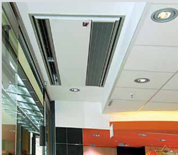
ORBIS ... -AK monteret i nedhængt loft med alu-blændramme
