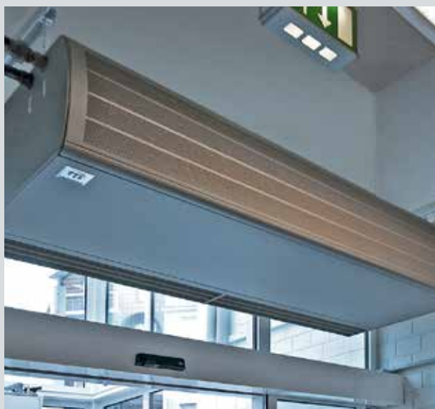
ORBIS monteret synligt - med brug af Vario-tilslutning (gennemgang i enhedens side)
