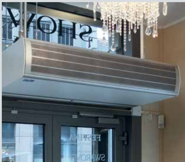
ORBIS monteret synligt - standardinstallation (STE)
