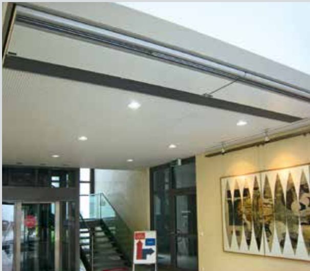
ORBIS ... -AK monteret i nedhængt loft med alu-blændramme, Funktionsprincip standardinstallation (STE)
