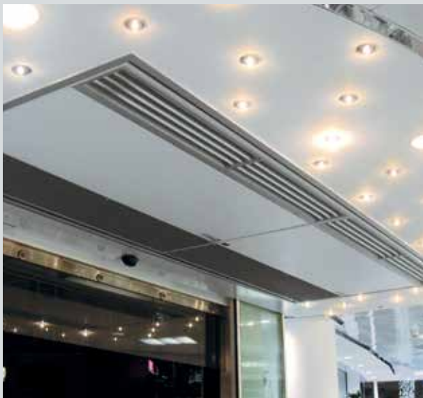
ORBIS ... -AK monteret i nedhængt loft med alu-blændramme, Funktionsprincip: indbygget som AWE version
