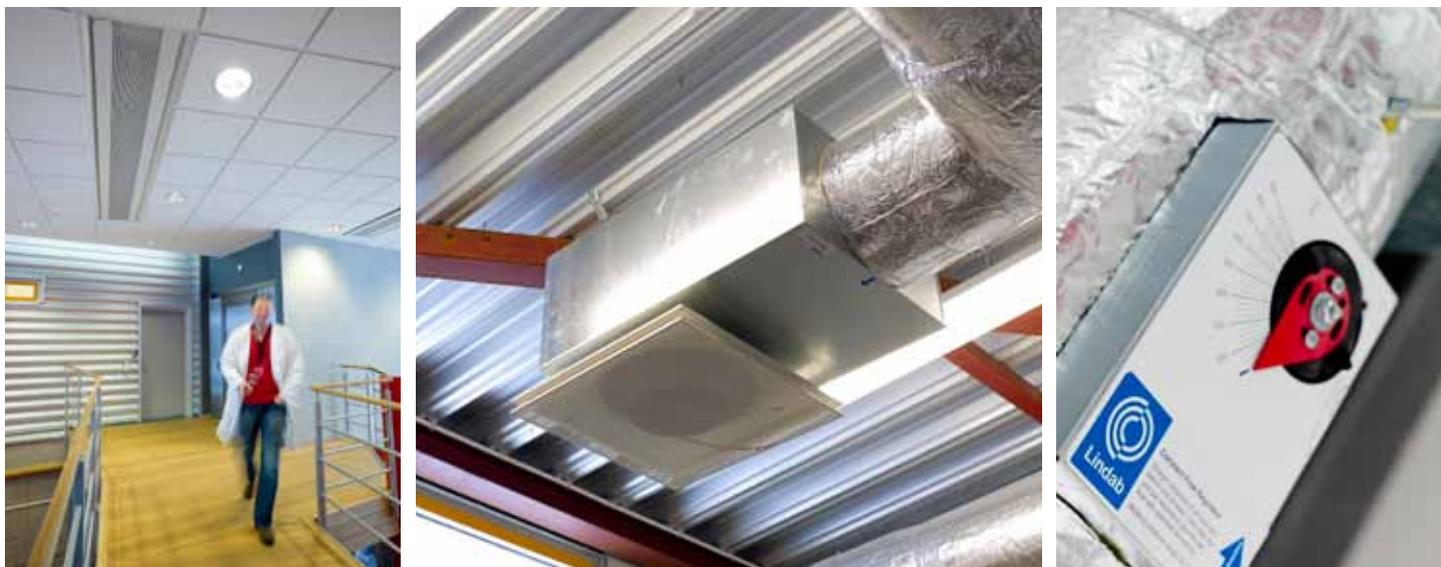
Lindabs Kühlbalken Professor, der neue Anschlusskasten MBB und die Konstantvolumenstromregler sind für das neue Raumklima bei Skruf Snus verantwortlich.
