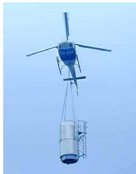
Einer der Schalldämpfer, den IVK speziell für Energent entwickelt hat, auf dem Weg zum Installationsort.
