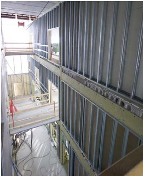
Die ca. 18 000 m<sup>2</sup> große Klinik Brinkåsen wird für die Betreuung von 82 Straftätern gebaut. Das Bild zeigt RdBX-Ständer in den Zwischenwänden des Eingangsgebäudes – die gesamte Zwischenwandfläche beläuft sich auf 14 500 m<sup>2</sup>.
