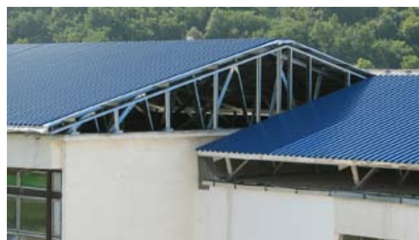
Die Gebäude des regionalen Wasserwerks im nordungarischen Lázberc haben dank Lindabs Roof Renovation System neue, dichte und strapazierfähige Dächer erhalten.
