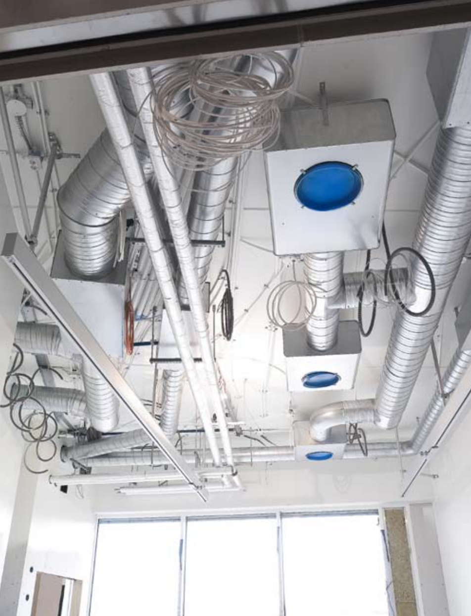
Die 54 Isolierzimmer der neuen Infektionsklinik sind installationstechnisch identisch ausgestattet. Da die Anlage in CADvent gezeichnet wurde, kann jedes Zimmer mit kompletten, fertig zugeschnittenen und mit Zeichnungen versehenen „Bausätzen“ beliefert werden.
