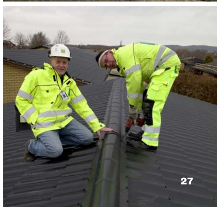
Projektleiter Bent Kaad und Monteur Bengt Månsson von RE-Väla Plåt freuen sich über eine unkomplizierte Zusammenarbeit und Lindabs effizientes Dachrenovierungssystem.
