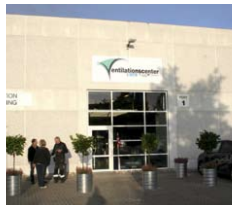
Im Ventilationscenter in Hvidovre steht der Kunde im Mittelpunkt – und erhält die Produkte der Branchenführer im Bereich Lüftung und Raumklima aus einer Hand.
