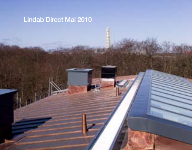
Gefalzte Bahnen auf dem erhöhten Ventilationsraum, traditionelle Blechtafeln auf dem alten Dach und Lindab Rainline – alles komplett aus Kupfer. Das Ergebnis: Ein Dach, das sich sehen lassen kann!
