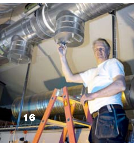
Sven-Erik Nilsson, Sydtotal (links), kontrolliert eine Inspektionsklappe im großen Ventilationsraum.
