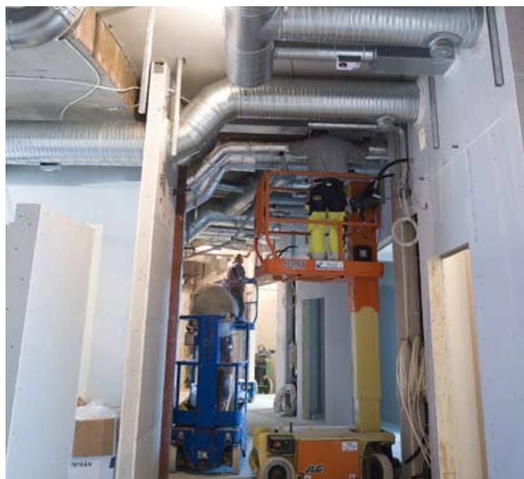
Die 54 Isolierzimmer der neuen Infektionsklinik sind installationstechnisch identisch ausgestattet. Da die Anlage in CADvent gezeichnet wurde, kann jedes Zimmer mit kompletten, fertig zugeschnittenen und mit Zeichnungen versehenen „Bausätzen“ beliefert werden.
