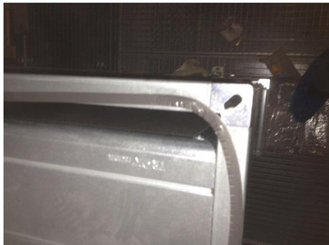
Bild 7: Rundgeklebte Dichtung
