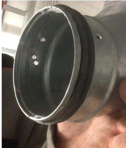
Bild 4: Mehrfach montierte Luftleitung, unter Missachtung der Hersteller-Montageanleitung
