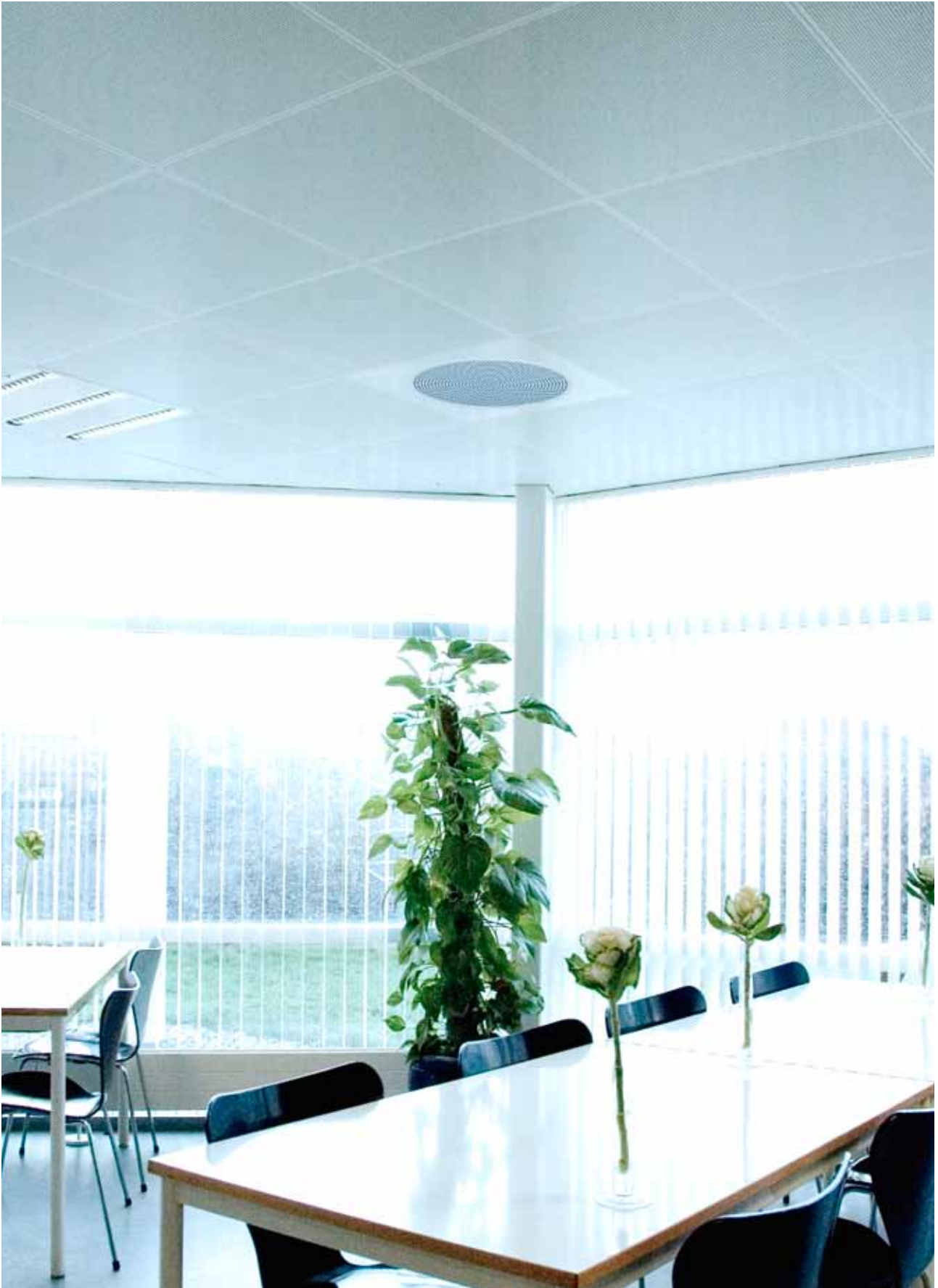
PC7, integriert in Luxalon-Aufbaudecke mit angepasster Modulplatte vom Typ LM.
