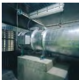
Fläkten precisionsstyr luftmängden och den hastighet med vilken den leds genom systemet. Fläkten är placerad centralt på det undre planet och har på båda sidor packats in i två lager bullerabsorberande material.
